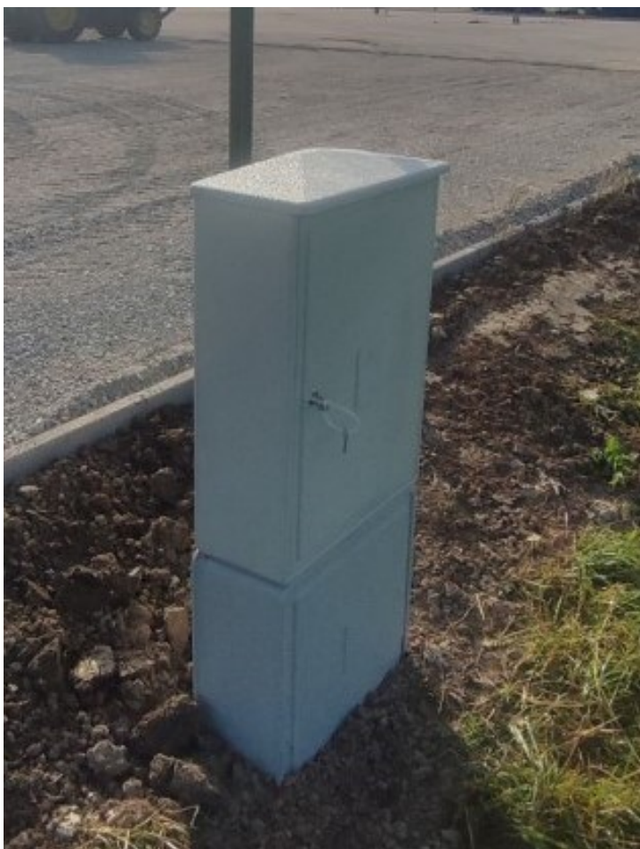
Fotografija 19: Elektro omarica s stikali za srednje nogometno igrišče
